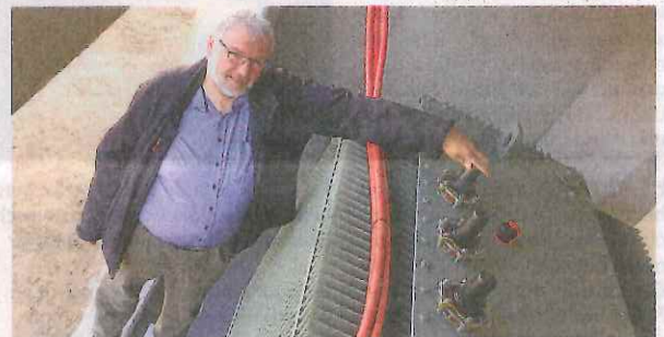
Die Wechselrichter und Transformatoren für den Batteriespeicher in Bordesholm sind angeliefert worden und werden eingebaut. Insgesamt 70 Tonnen.
