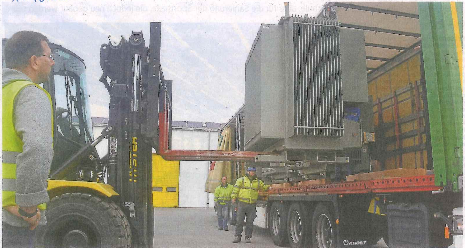
Die Wechselrichter und Transformatoren, insgesamt 70 Tonnen schwer, für den Batteriespeicher in Bordesholm werden abgeladen.
