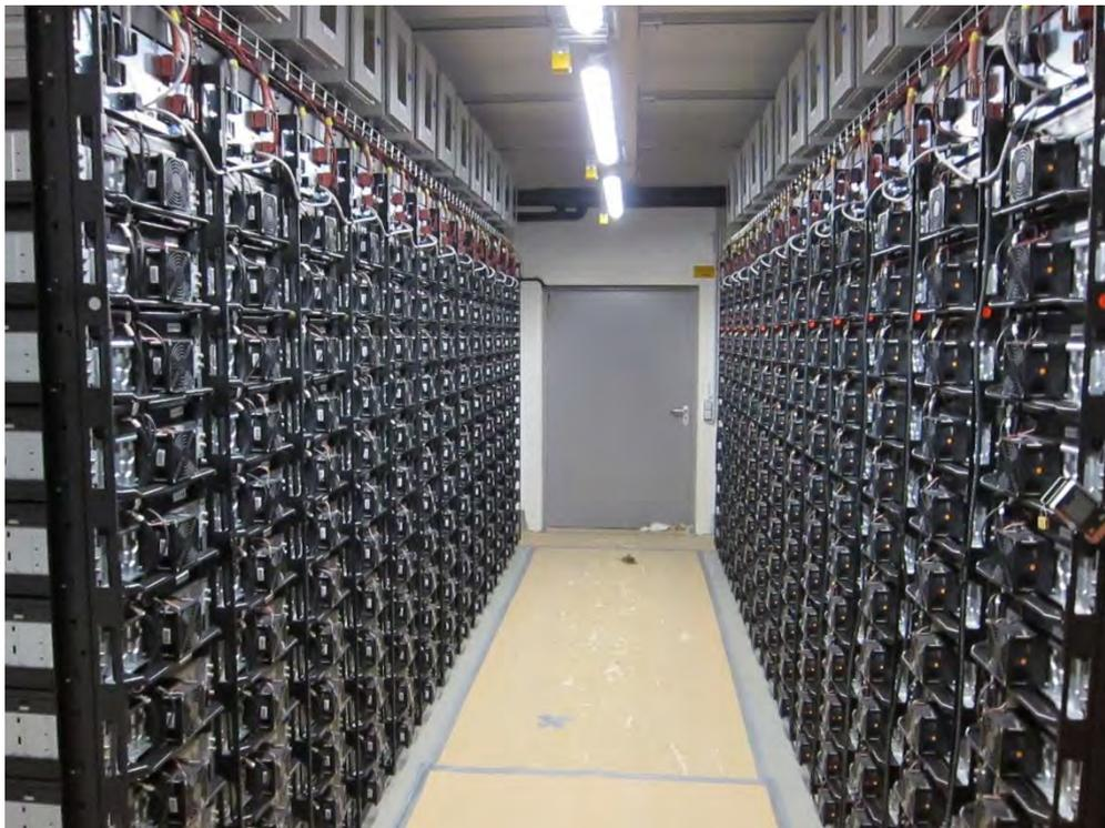
Abbildung 15: Eine Reihe mit Racks von Batteriezellen
