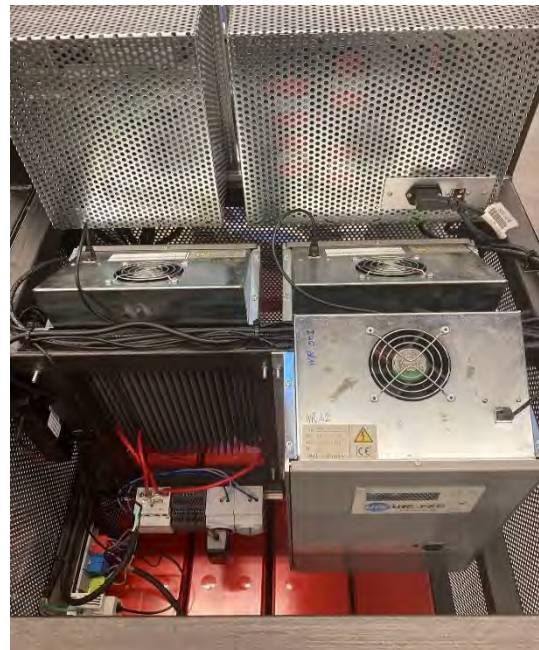
Abbildung 7 Wechselrichter im Rack
